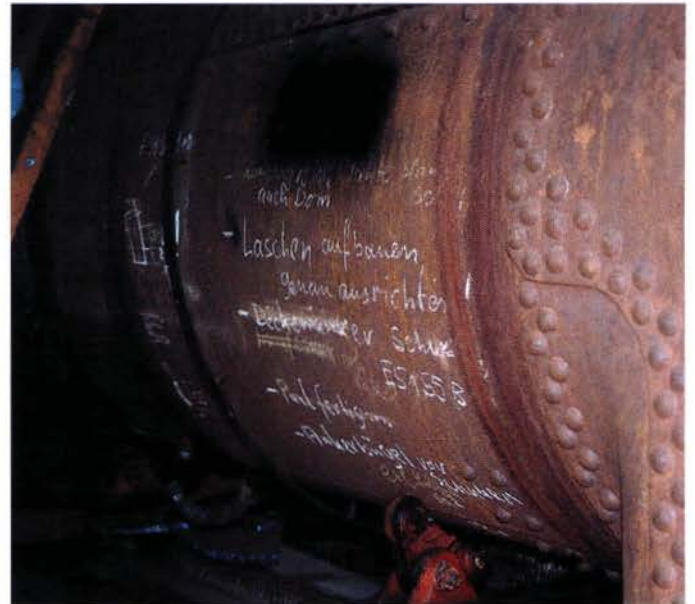
Der Kessel als Notzblock: Lok 184 wird komplett instand gesetzt.
